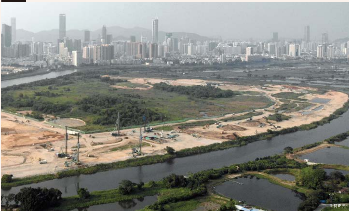
部分落馬洲河套區的前期工程入侵濕地及圍欄以內的地區。
